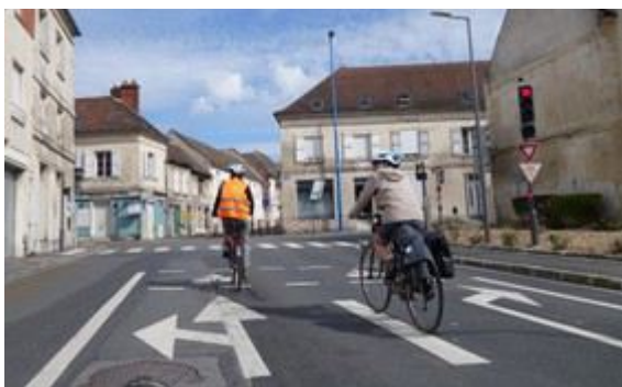
SAS Vélo au feu, équipé d'un cédez le passage cycliste
